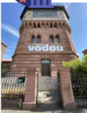
Le musée Vodou se situe dans un château d'eau de 1878. / OSB
